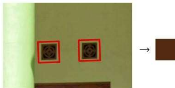
Gambar 4. Ventilasi Ruangan Masjid Agung Kota Probolinggo
